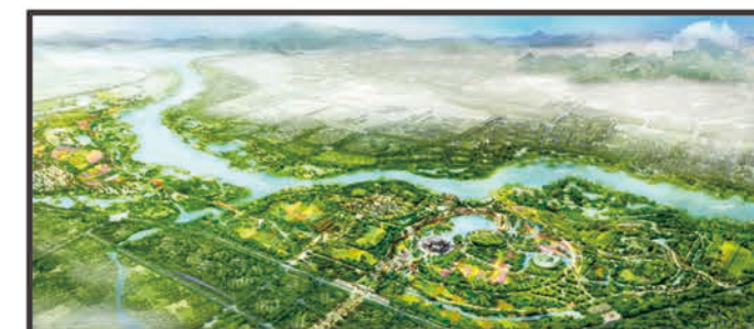
北京世园会地下综合管廊工程
